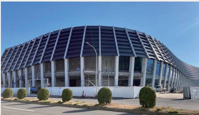
建設が進む「ポートメッセなごや・新第1展示館」(名古屋市中区)※2022年1月8日撮影
